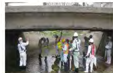
【H26 上五島での点検業務状況】
