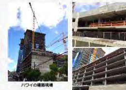
ハワイの建設現場
