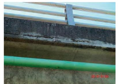
元触橋の点検 (左写真より、点検の様子、橋梁端部での段差、地覆部の遊離石灰)
