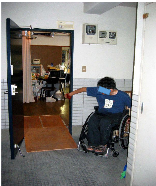
図13 障がい者宅の電動ドア電動スロープ
