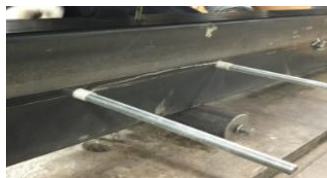
Photo 1 貫通した寸切り
