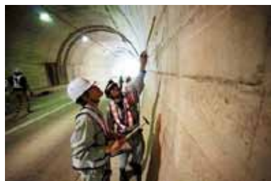
千藤トンネル 実習状況
