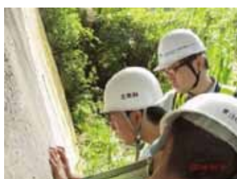
現場実習：クラック幅を測定
