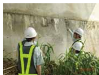
現場実習：損傷状態の説明
