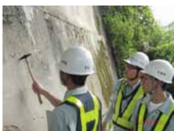
現場実習：打音検査
