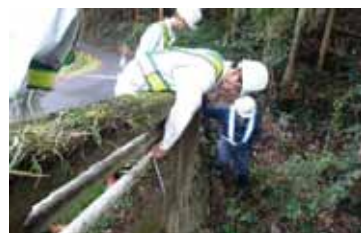
橋梁上部工点検
