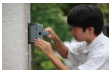
鉄筋探査実習①
