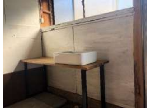
写真8 改修後（キッチン）
