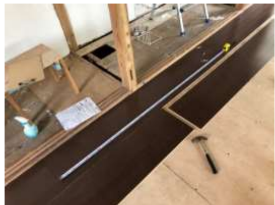
写真 6 フローリング設置風景
