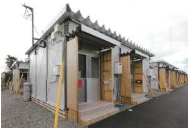
図 5 プレハブ応急仮設住宅外観 4)
