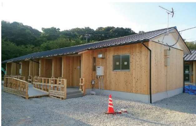
図1 木造応急仮設住宅外観 1)
