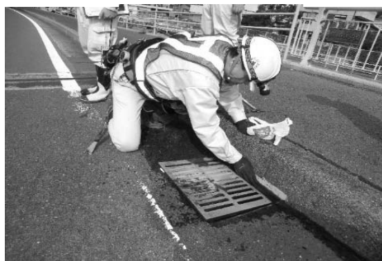
橋梁点検・土砂清掃の様子
