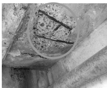
桁下部分の鉄筋露出
