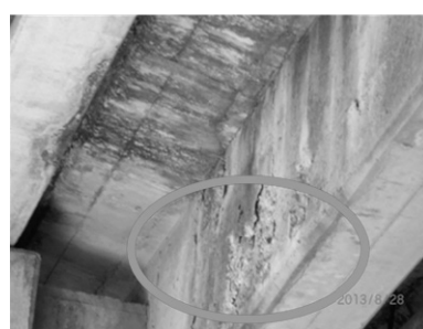
主桁側面コンクリート剥離
