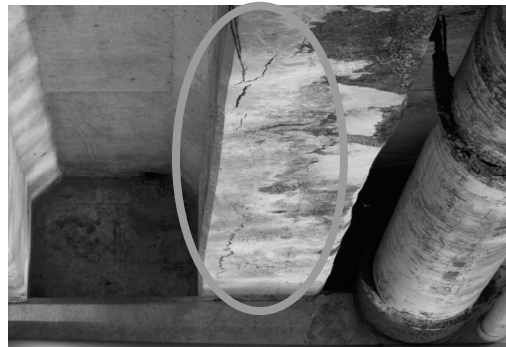
コンクリート桁のクラック
