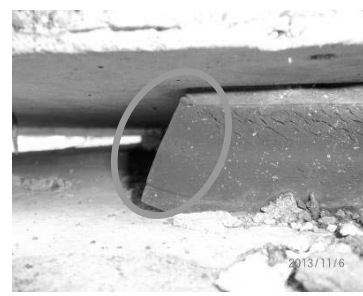
橋の動きによるゴム支承の変形
