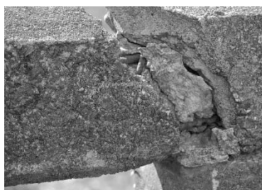
手摺コンクリート欠落
