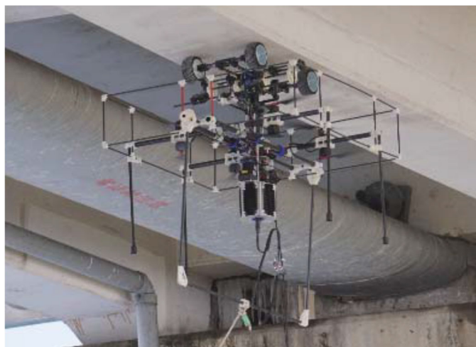
図 6.3.9 打音点検状況
