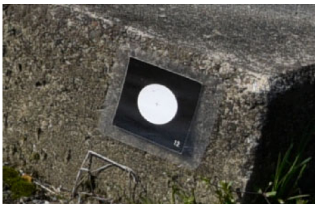
設置した 10cm 角のターゲット (地覆)
