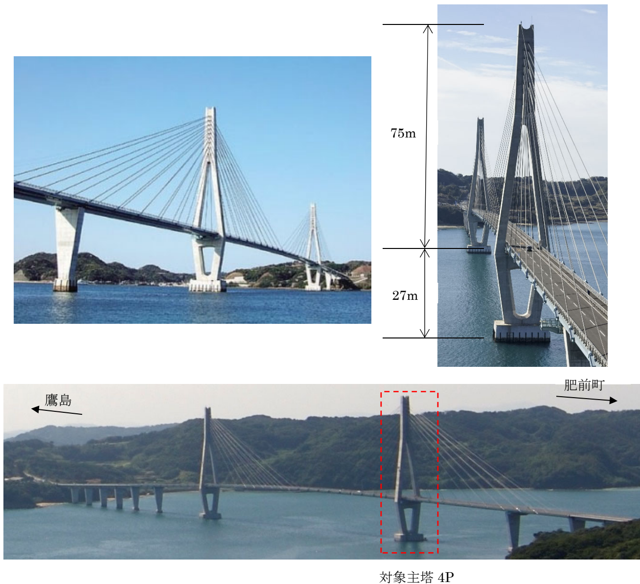
図 4.1.3 鷹島肥前大橋の全体
