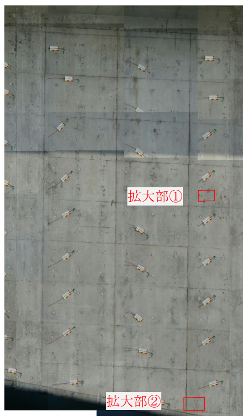
図 6.6.5 展開画像 (橋梁点検支援ロボット)
