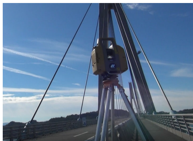
3Dレーザ計測状況
