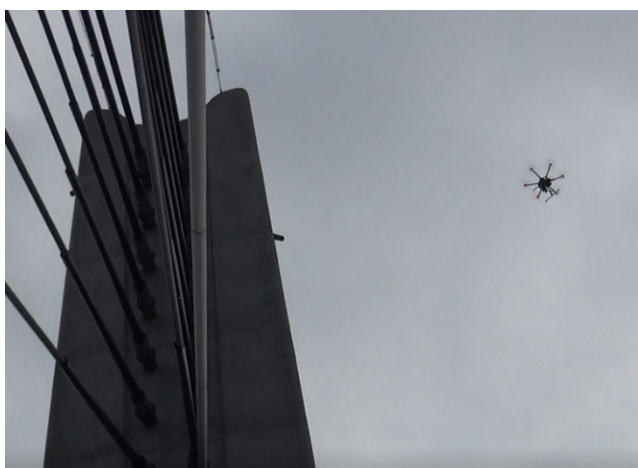
主塔撮影状況（頂部付近）
