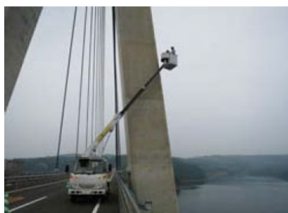
高所作業車による点検
