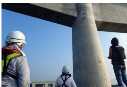
橋脚撮影状況
