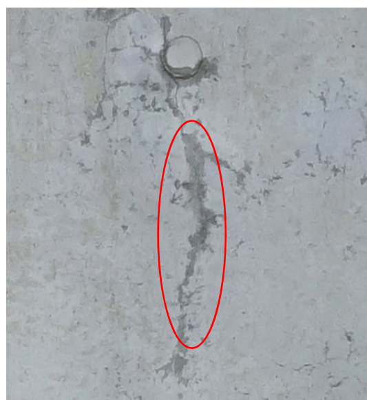
図4.5.2 0.5mm幅と検出された箇所
