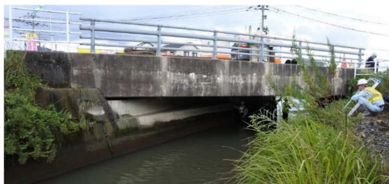
RC 床版橋（拡幅）
