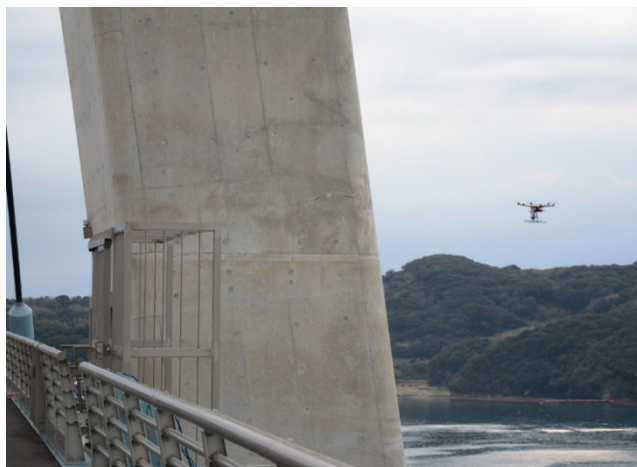
主塔撮影状況（橋面付近）
