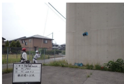
機材の搬出入
