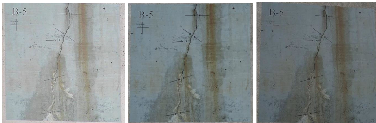
橋梁点検ロボットカメラ
