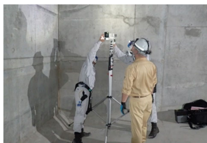
カメラの設置・準備 橋梁点検ロボットカメラ
