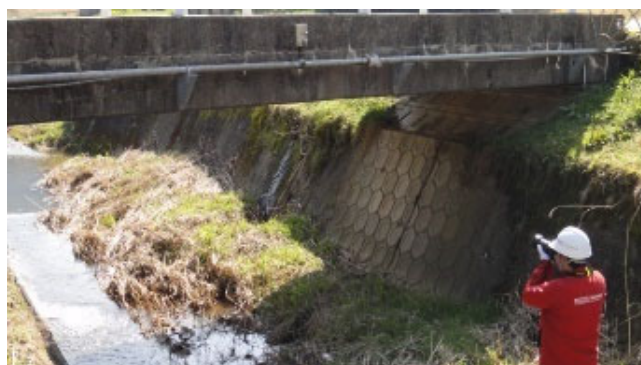
桁側面の撮影（手撮り）
