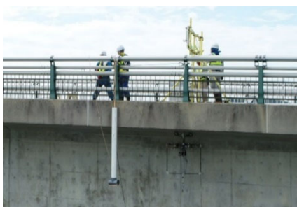
張出下面の点検状況 打音機能付飛行ロボット
