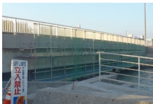
吊足場による点検
