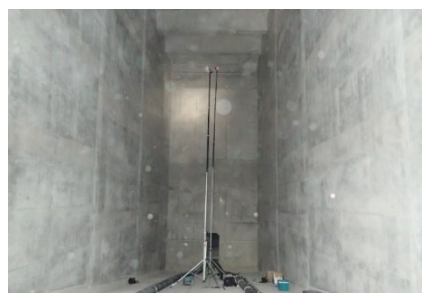
桁内撮影状況
