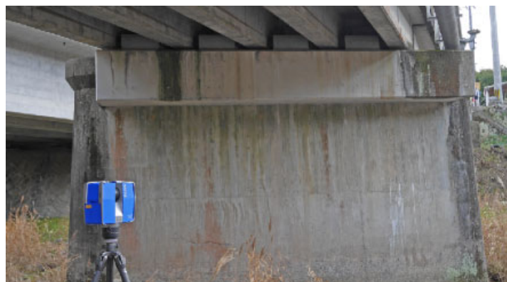
3D レーザ計測状況
