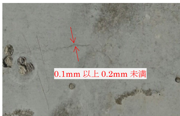
図 6.6.7 展開画像 拡大部① (橋梁点検支援ロボット『見る・診る』)
