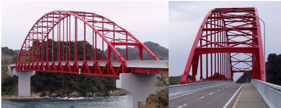
写真-2.1 全景写真
