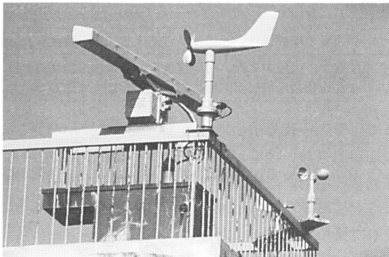
写真1 アンテナ部の拡大写真
