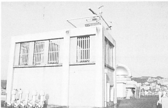
写真2 教育学部屋上部
