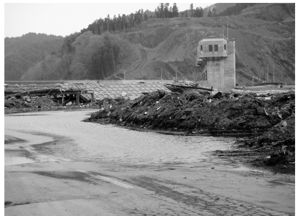
写真3. 海岸堤防と地盤沈下（平成23年4月27日撮影）
