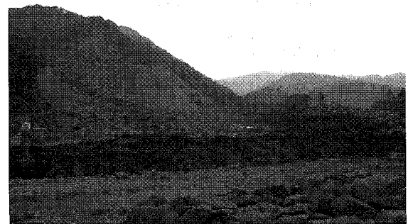
一迫川小川原付近の大河道閉塞の復旧工事
