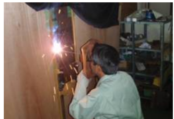
写真-4 溶接状況
