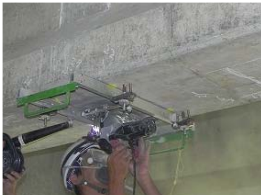
写真-3 スリット切削状況
