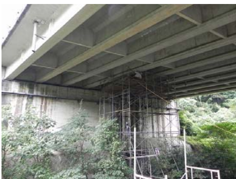
写真-1 調査橋梁
