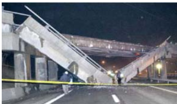
写真 1.1.1 ペンシルバニアの落橋事故 4)
