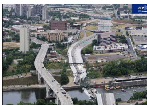
写真 1.1.2 ミネアポリスの落橋事故 6)
