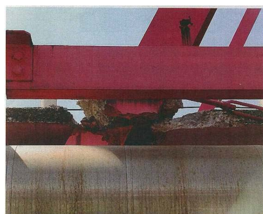
写真 1.1.3 木曾川橋梁のトラス斜材の破断 8)
