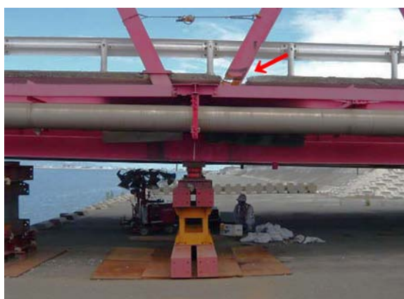
写真 1.1.3 木曾川橋梁のトラス斜材の破断 8)
