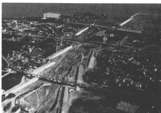
写真-9 導流堤下流域の空撮 （建設省雲仙復興工事事務所提供）
