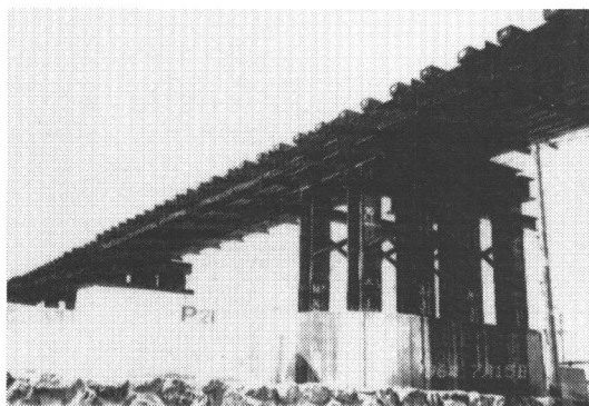
写真-7 島原鉄道の仮設高架橋梁（中尾川）
