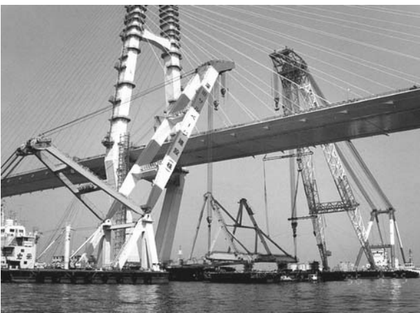
写真-2 名港中央大橋の大型起重機船による斜ベント撤去の事例
