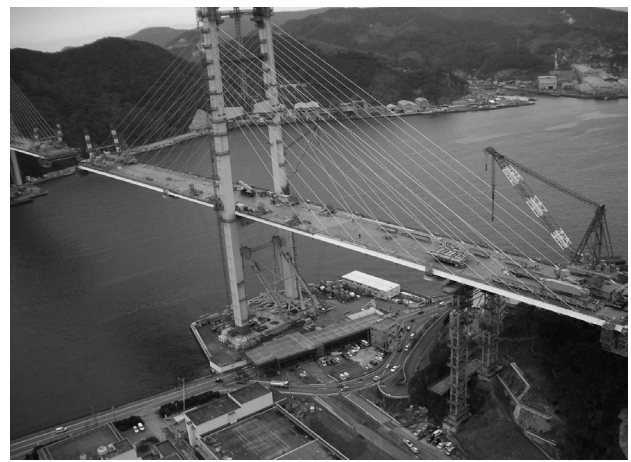
写真-9 斜ベントスイング撤去状況
