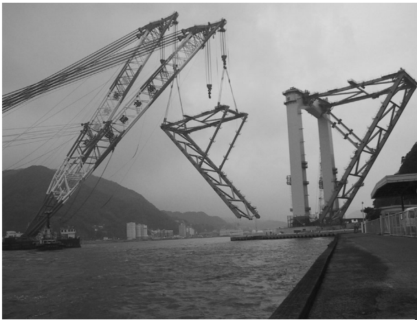
写真-1 斜ベントの設置状況
