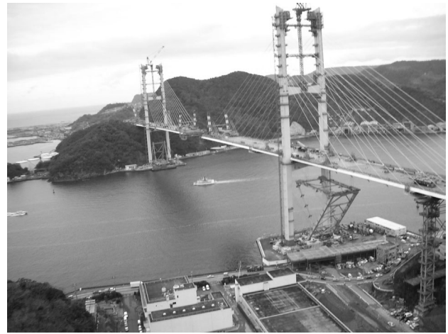
写真-7 斜ベント直下吊下げ状況
