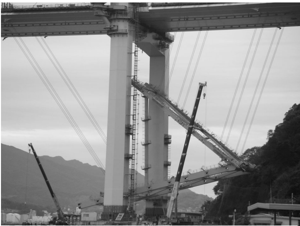
写真-8 斜ベントスイング撤去状況近景
