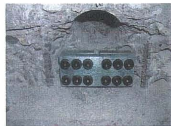
写真-3 接続治具設置完了
