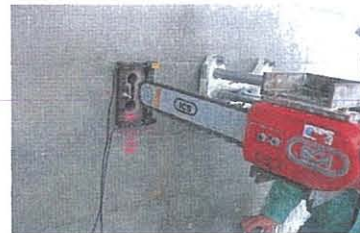
写真-4 スロット削孔状況
