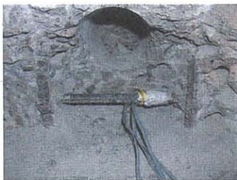
写真-1 ゲージ貼付状況
