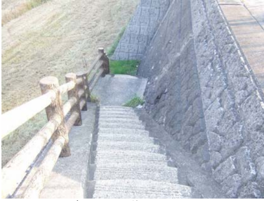
写真-16 階段による入口 平成 23 年 12 月 高橋和雄 撮影
