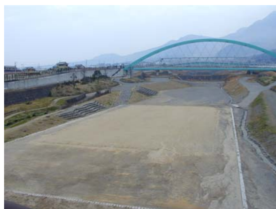
写真-2 遊砂地を整地した広場 平成 16 年 10 月 高橋和雄 撮影
