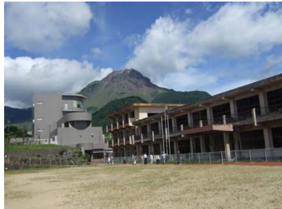
写真－7 被災した小学校校舎の保存と 大野木場砂防みらい館 平成20年8月 高橋和雄 撮影
