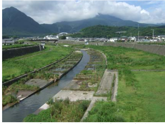
写真-17 中尾川導流工の全景 平成 23 年 7 月 高橋和雄 撮影
