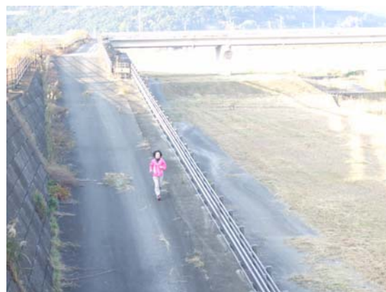
写真-15 車が進入可能な進入路 平成 23 年 12 月 高橋和雄 撮影
