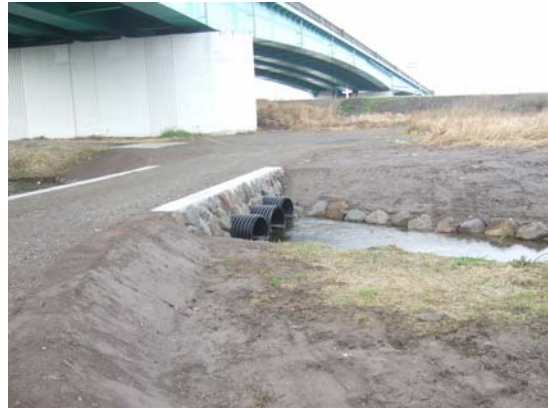
写真-4 広場と通路の排水対策 平成24年3月 高橋和雄 撮影
